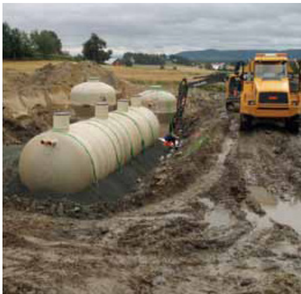
Slamavskiller med infiltrasjon under bygging.
